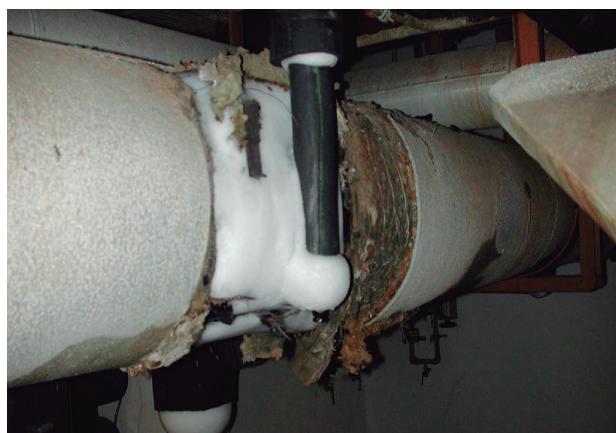
Figura 3: Hielo en el equipamiento: inicialmente el aislamiento funciona perfectamente, pero después de un uso prolongado se forma condensación e incluso hielo
