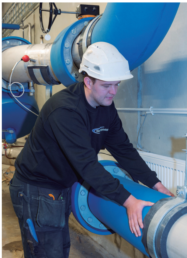
Figura 7: Ahora Armacell ofrece su soporte para tuberías en versión Armafix Ultima para utilizarlo con el material aislante Armaflex Ultima de baja emisión de humo
